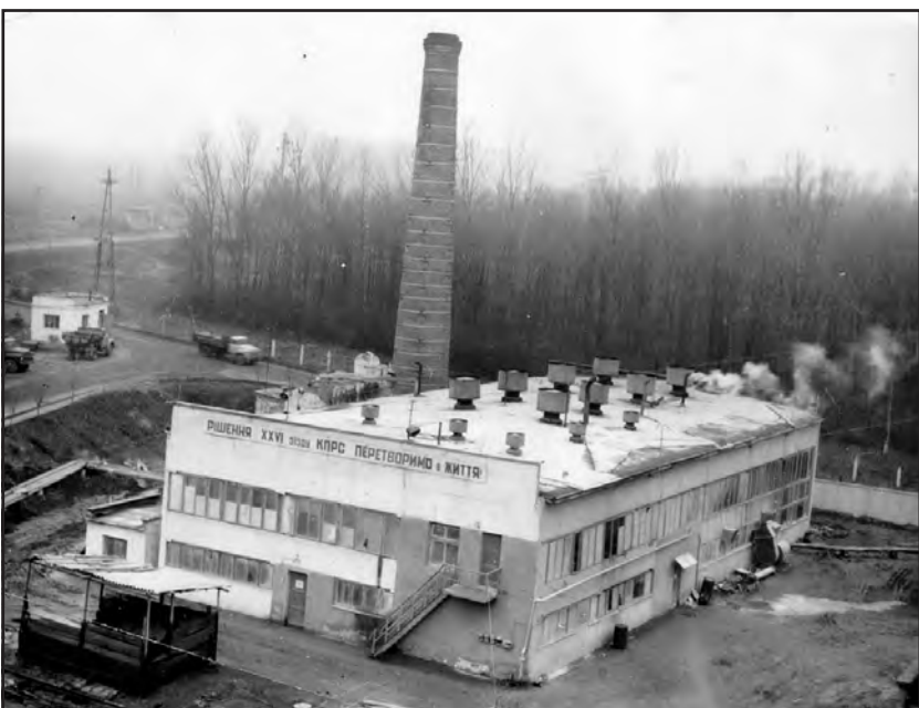
Серце заводу — котельня, фото 1984 року.
